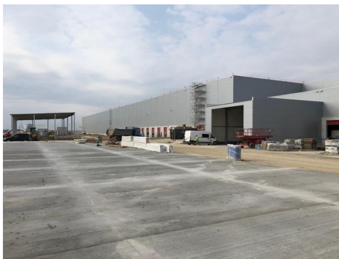
Budowa centrum dystrybucyjnego Dino Polska S.A.
