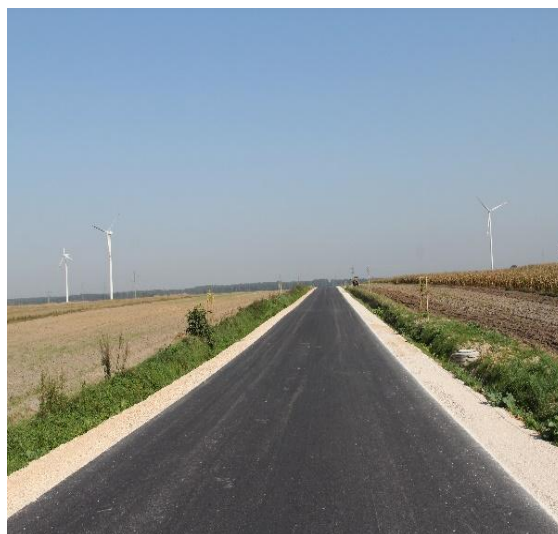
Przebudowa drogi powiatowej Nr 1913E na odcinku Żarnowica - Wolbórz
