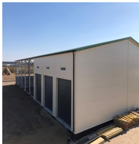
Rozbudowa oczyszczalni ścieków w Wolborzu
