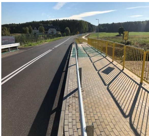
Przebudowa drogi gminnej Wolbórz – Zwierzyniec - Modrzewek - Młoszów wraz z ul. Gadki
