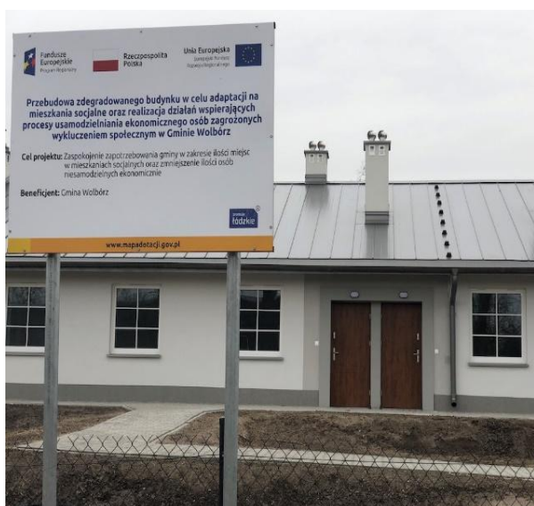
Przebudowa zdegradowanego budynku w celu adaptacji na mieszkania socjalne
