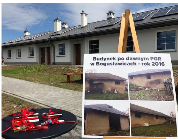
Przebudowa zdegradowanego budynku w celu adaptacji na mieszkania socjalne
