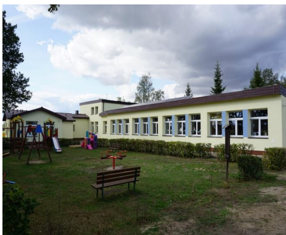
Rozbudowa, przebudowa i nadbudowa z termomodernizacją SP w Proszeniu
