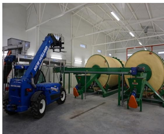
Rozbudowa oczyszczalni ścieków w Wolborzu
