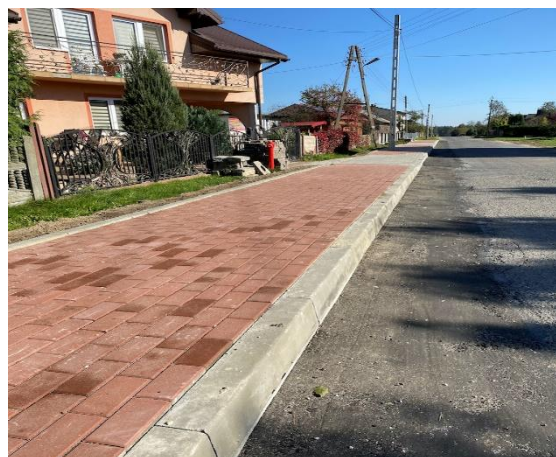
Przebudowa drogi powiatowej Nr 1526E w m. Swolszewice Duże w zakresie chodnika
