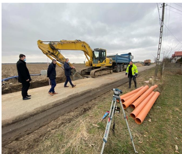
Budowa kanalizacji sanitarnej w Komornikach
