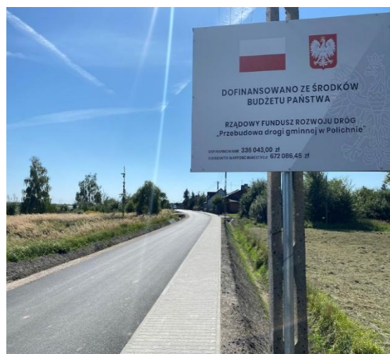
Przebudowa drogi gminnej w Polichnie
