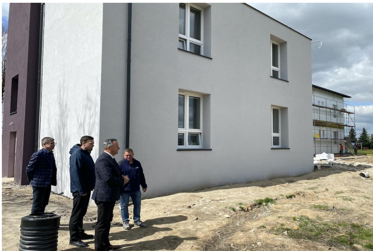
Remontowany budynek Szkoły Podstawowej w Komornikach
