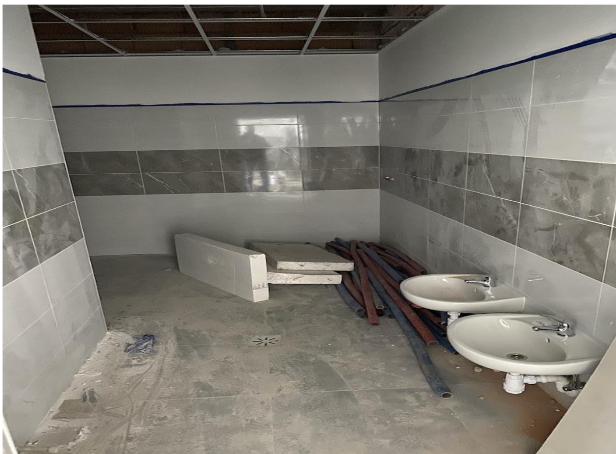
Remontowane sanitariaty w Szkole Podstawowej w Komornikach
