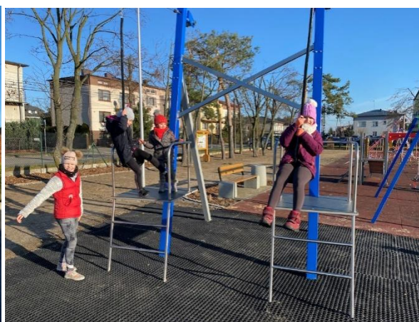
Budowa strefy rekreacyjno - wypoczynkowej na kompleksie rekreacyjno - sportowym w Wolborzu
