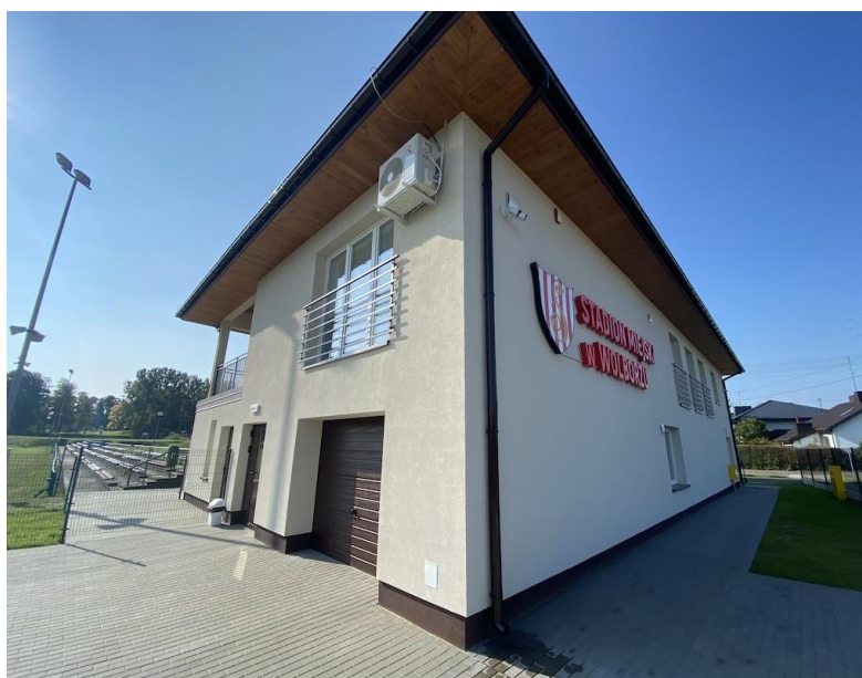
Budynek szatni – Stadion Miejski w Wolborzu
